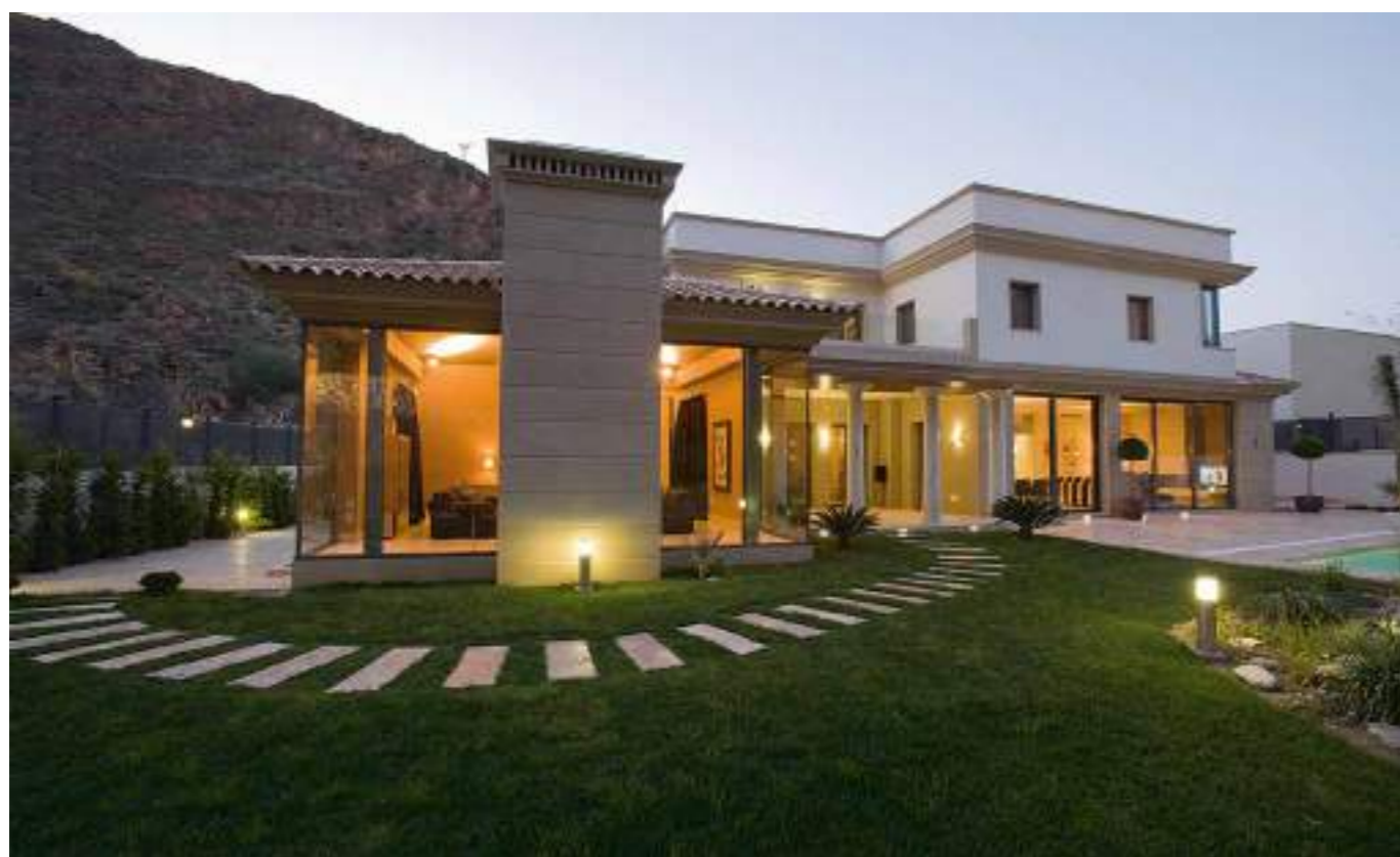
Fuente: Cuellar Arquitectura del Mármol
